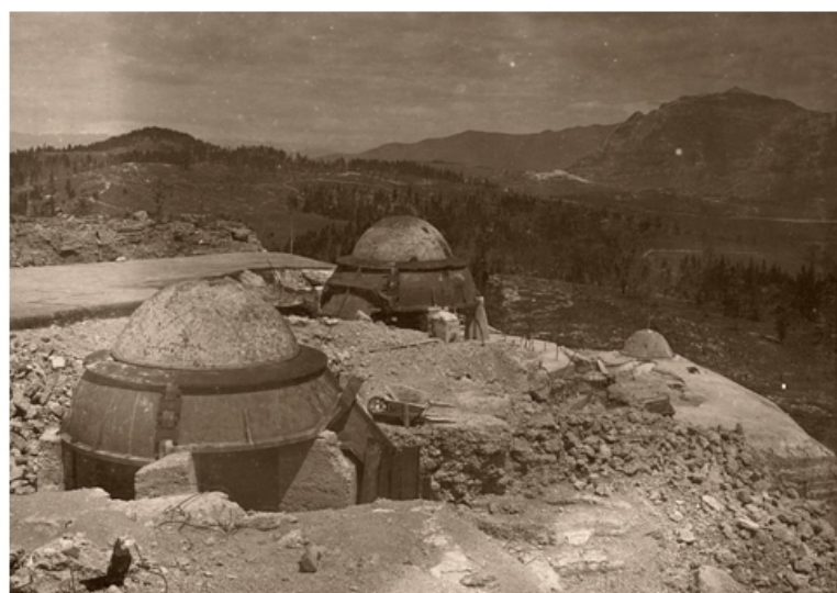
Rekonstrukce dělových věží pevnosti Lusern
